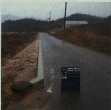
井辺団地 縁石工:完成
