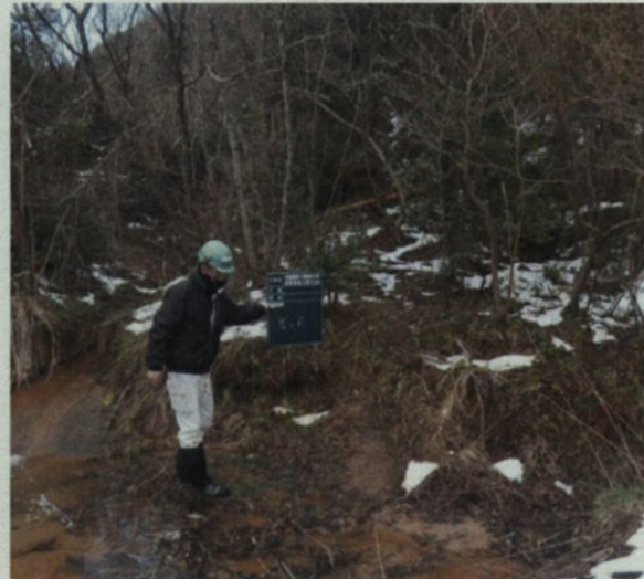
鳥取2.3団地 シュート工:着工前
