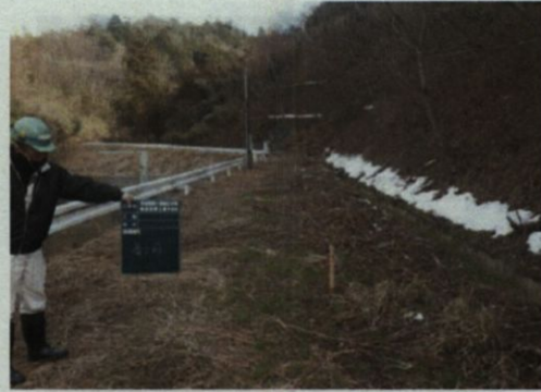
掛津団地 舗装工:着工前
