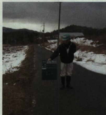
井辺団地 縁石工:着工前
