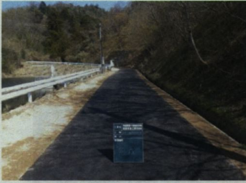
掛津団地 舗装工:完成
