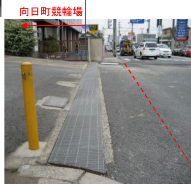
<グレーチング蓋の滑り止め対策> （既に滑り止め対策用蓋） ■歩行空間の明示L=20m
