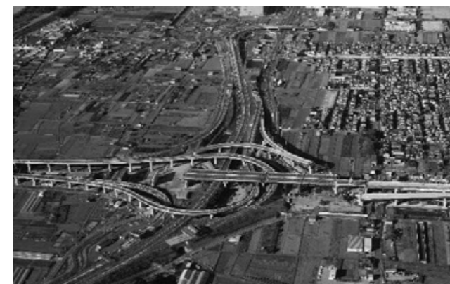
新名神高速道路 城陽 JCT・IC (提供：NEXCO 西日本)
