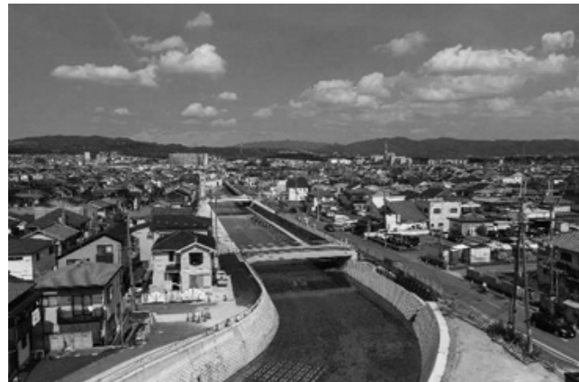
河川改修後の古川
