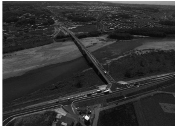
国道163号（東中央線木津川橋）
