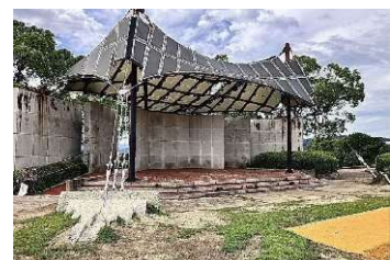
野外ステージ改修
