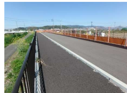
(市道二階堂川口2号線交差付近)
