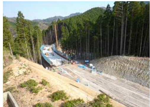
施工の状況（奥山田1号橋）
