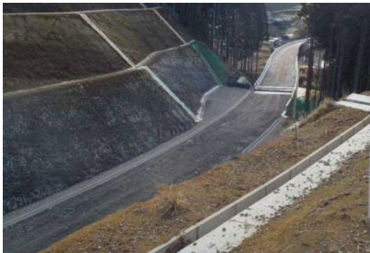
施工の状況（切土部）
