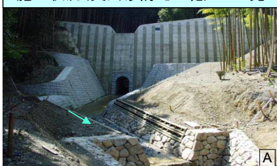
施工状況(支川砂防えん堤) H17完
