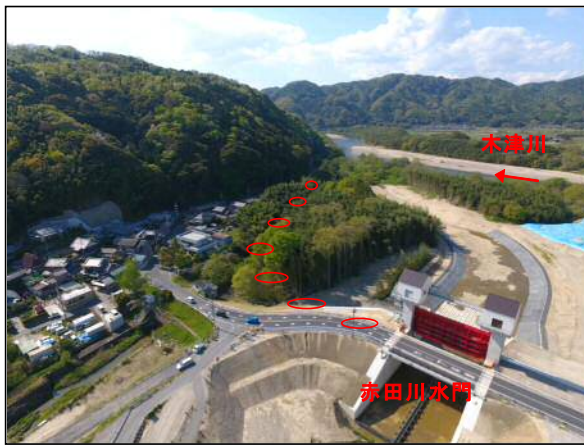
整備区間の状況
