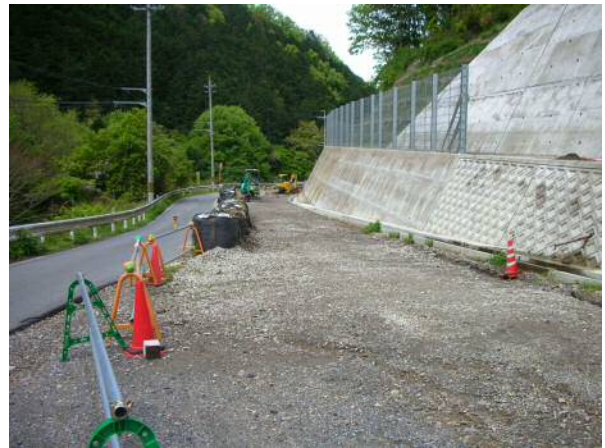
工事進捗状況
