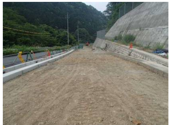
工事進捗状況
