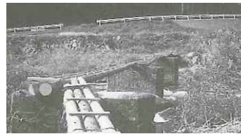
C.コンクリート製の橋脚
