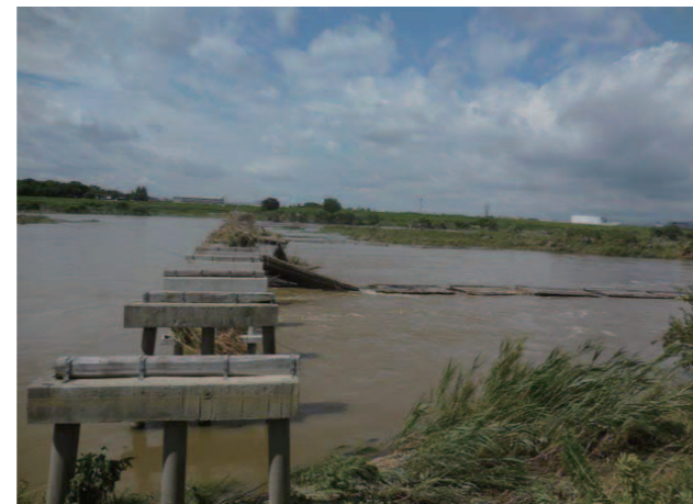
橋桁と橋板はワイヤーロープでしっかりと橋脚につなげているため、流れ去ってしまうことはありません。上から見ると、橋板が筏流しのように並んで見えます。
