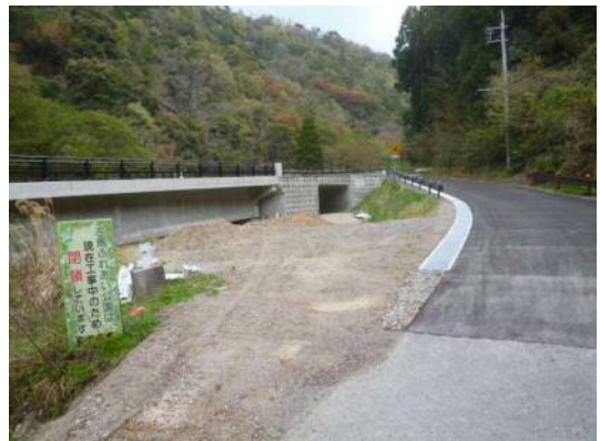
工事進捗状況
