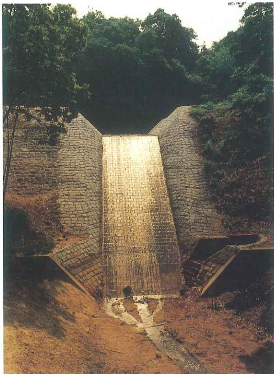
平成5年に完成された石堰堤(平成の大修理)
