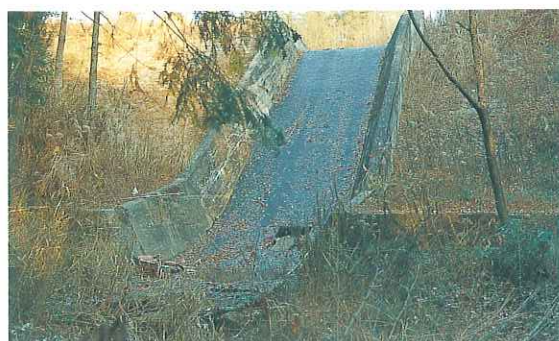
平成の大修理前
