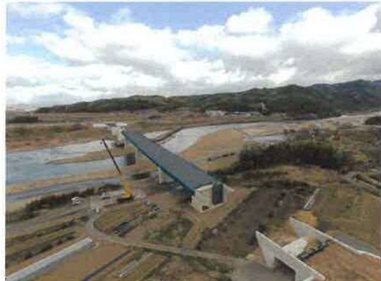
施工の状況（木津川渡河橋りょう部）
