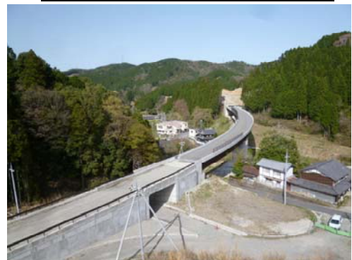
施工の状況（奥山田2号橋）
