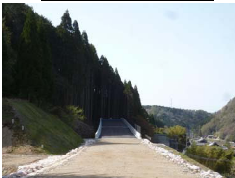
施工の状況（鋼製栈橋）
