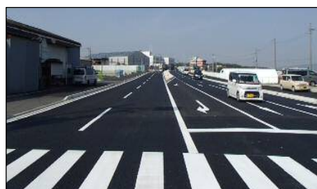
施工の状況(内里高野道線)
