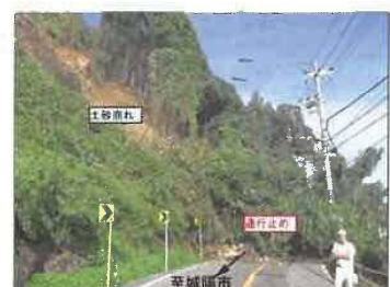
【被災の様子 平成25年9月】
