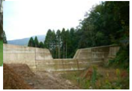
既設の砂防堰堤を嵩上、 上流には新規に砂防堰 堤を整備
