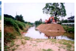
堆積土砂の浚渫
