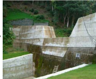
既設の砂防堰堤を嵩上、 上流には新規に砂防堰 堤を整備
