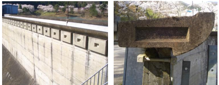
景観に配慮された大野ダムの堤頂部
