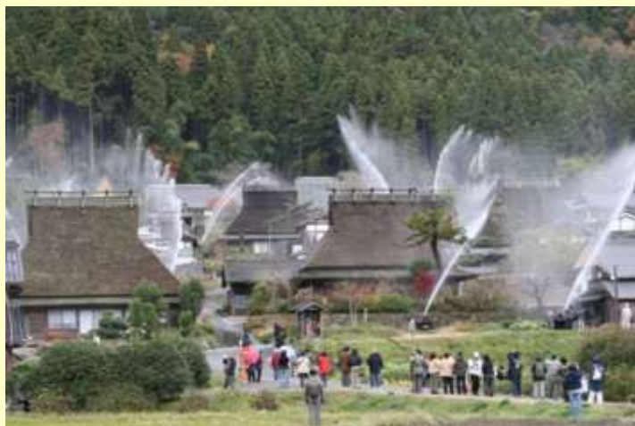
放水銃一斉点検の光景
