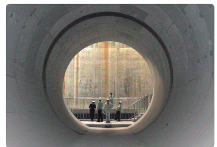
●いろは呑龍トンネルの内部
