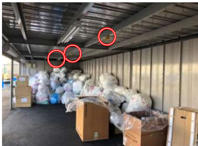
30 31 スマートセンサーを天井に設置し廃棄物の堆積状況を モニタリングする様子
