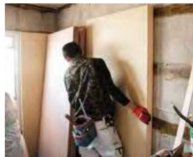
壁の内側に断熱する内貼り断熱
