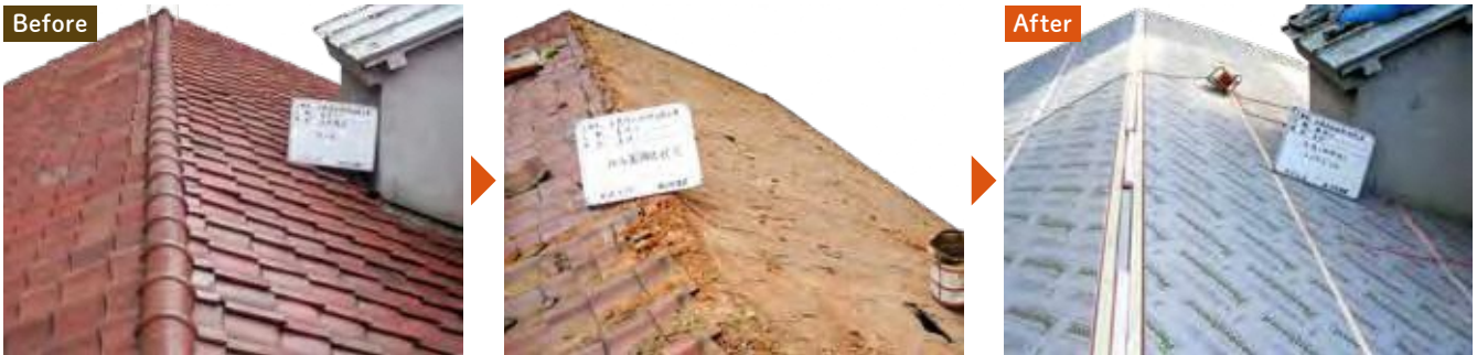
屋根断熱工事のビフォー（左）瓦撤去後（中）断熱材施工後（右）
