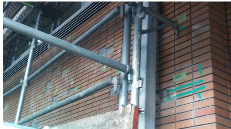
② タイル張替え・樹脂注入
