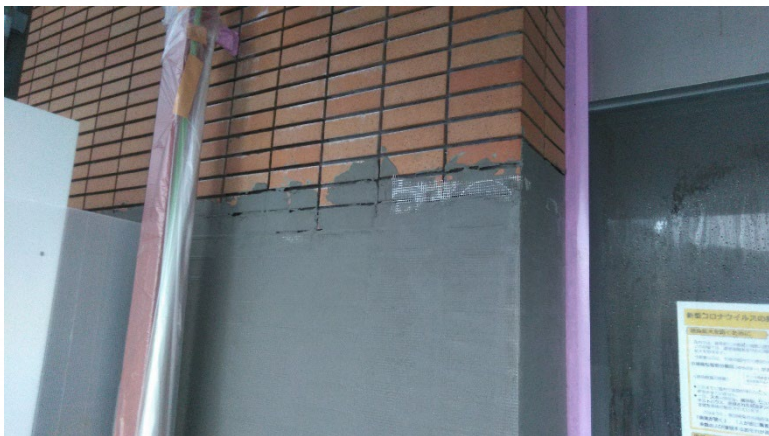
③ タイル目地埋め・不陸調整
