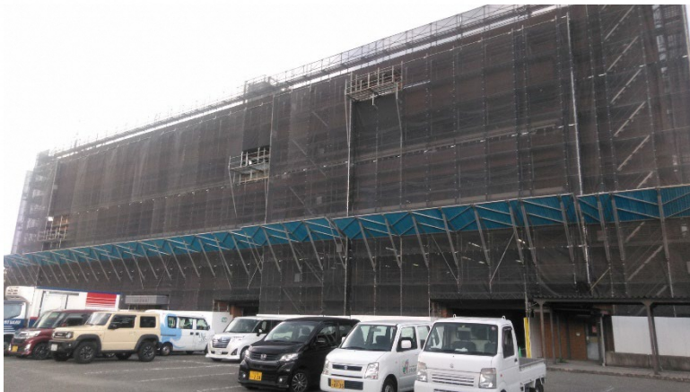
① 足場仮設
