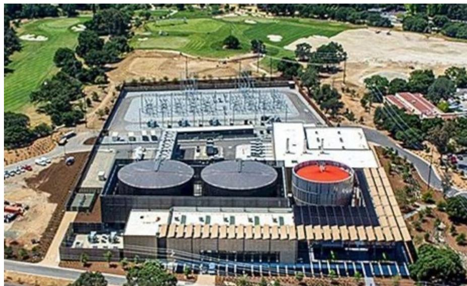
スタンフォード大学のエネルギーセンターでは、廃熱も利用し生成した温水・冷水を貯める巨大なタンクがあり、キャンパス内の冷暖房をまかなっている
