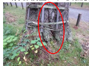
縦に亀裂も入っている
