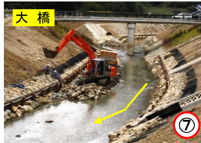
↑下流左岸より大橋を望む
