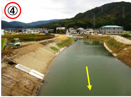
↑新松原橋より上流を望む
