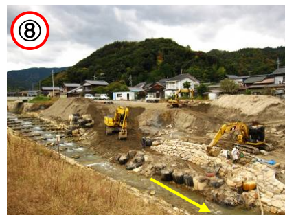
↑堂ノ下橋下流右岸側より親水広場を望む
