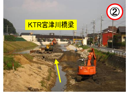
↑松原橋右岸側から下流を望む
