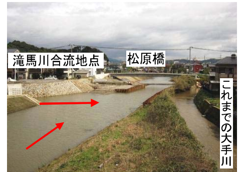
↑ 新松原橋より松原橋、滝馬川合流地点を望む (岸下建設)
