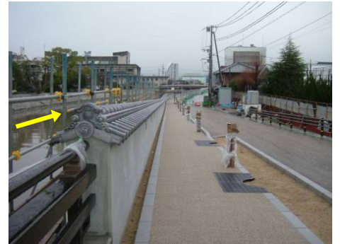
↑ 中橋付近から大手橋方面を望む
