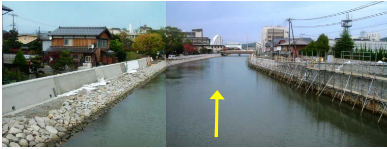
↑中橋より下流を望む。右岸側は宮津城城壁復元工事を進めています
