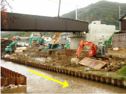
↑下流よりKTR宮津川橋梁を望む
