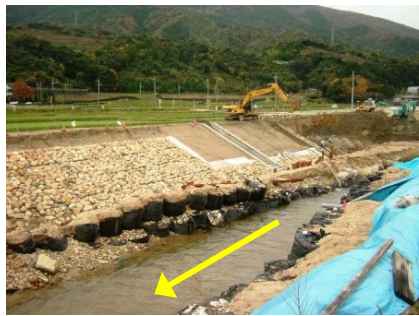
↑堂ノ下橋下流右岸護岸工事
