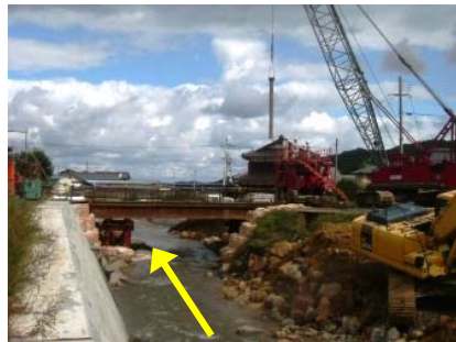
↑上流より生野神社橋を望む
