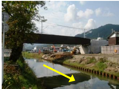
↑ KTR宮津川橋梁下流から松原橋方面を望む
