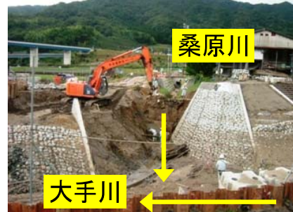
↑大手川左岸より桑原川合流地点を望む
