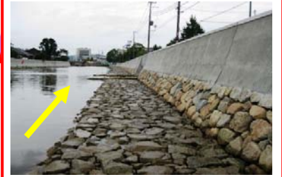
↑ 上流より下流を望む
