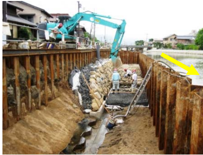
↑ 右岸側護岸工事を進めています
