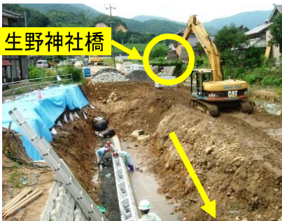
↑ 生野神社橋下流右岸側の護岸工事を進めています
