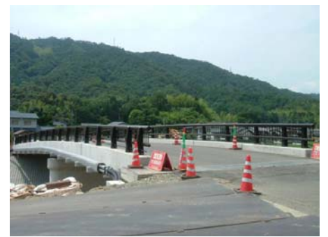
善光橋 金下建設 6月1日から通行可能となっていますが、現在も工事中です。 段差がありますので徐行お願いいたします
