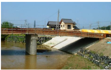
百合が丘橋上部工 日本ピーエス 橋桁がかかりました 現在通行止です ご迷惑をおかけしております
