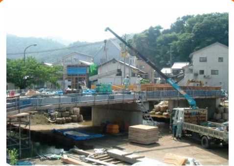
京口橋 極東興和 マルキ・大建JV 橋桁がかかりました
