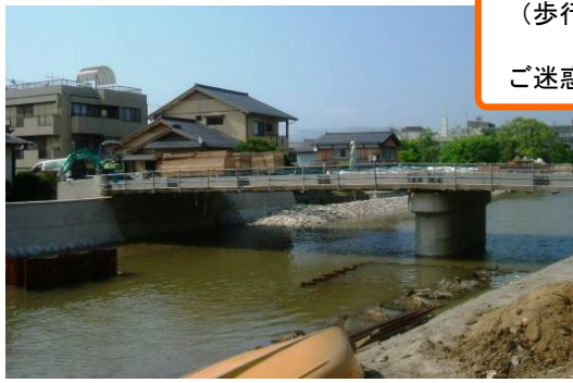
中橋架け替え工事 極東興和 橋桁がかかりました
