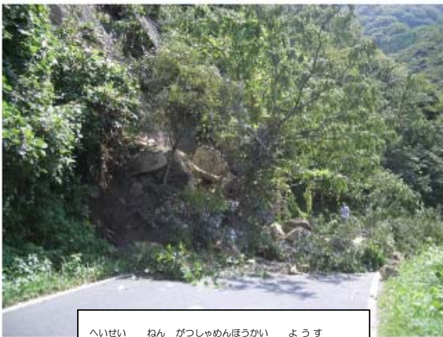
平成19年9月斜面崩壊の様子
