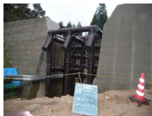
⑩ 組立て状況
