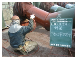
⑥ 錆びないように塗装を行います。
