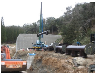
⑨ クレーン車を使って設置します。
