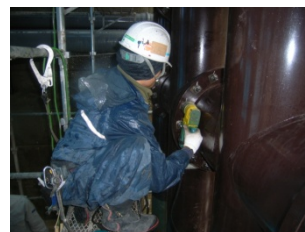
⑪ ボルトで締めて固定します。
