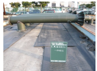
④ 鋼製スリットの部材の完成
