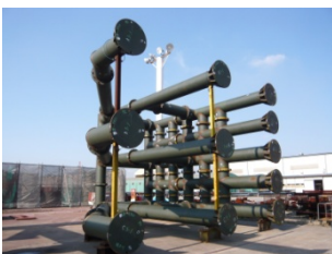
⑤ 製作された部材を仮に組み立てます。
