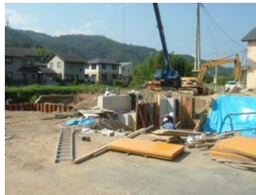
百合丘橋架け替え工事 金下・きしべJV ご迷惑をお掛けしています。 現在、通行止めです。
