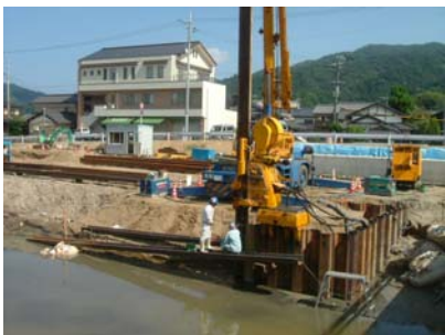
京口橋架け替え工事 金下・きしべJV
