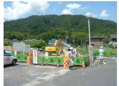
百合丘橋架け替え工事 金下・きしべJV ご迷惑をお掛けしています。 8月1日より通行止めです。
