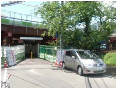
KTR宮津川橋りょう架け替え 工事 大鉄・金下JV
