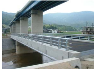
福田橋架け替え工事 (上部工)ドーピー建設工業
