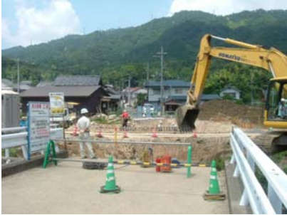
善光橋架け替え工事 金下建設 ご迷惑をお掛けしています。 現在、通行止めです。
