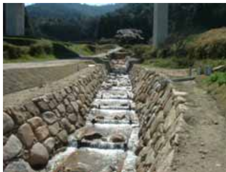
今福川のアンカー式空石積み工
