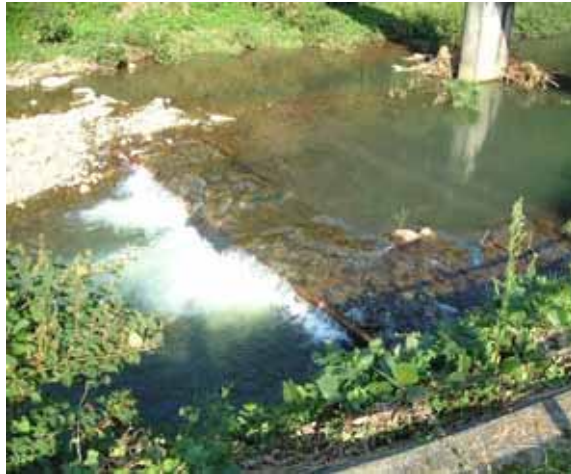
筒川の木工沈床落差工
