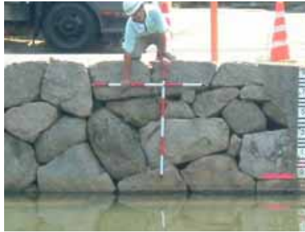
大手橋上流右岸の石積み
