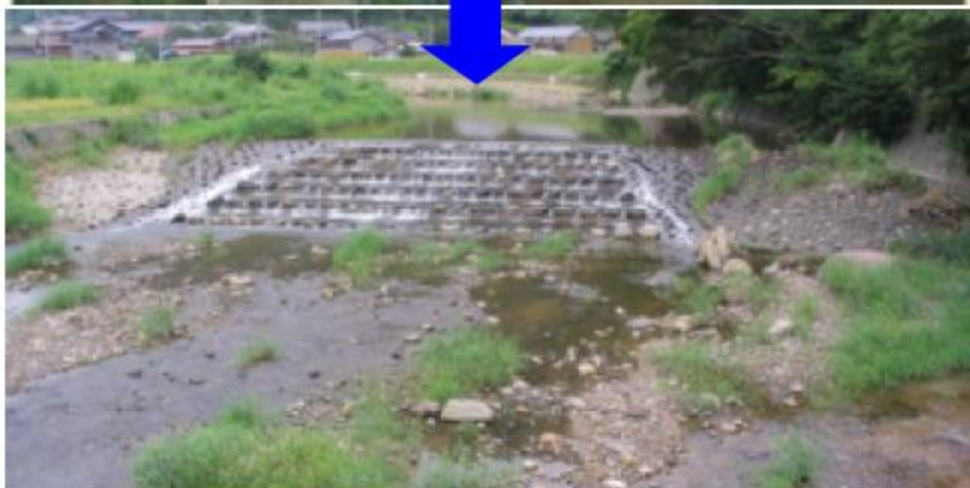
堰における魚道の整備
