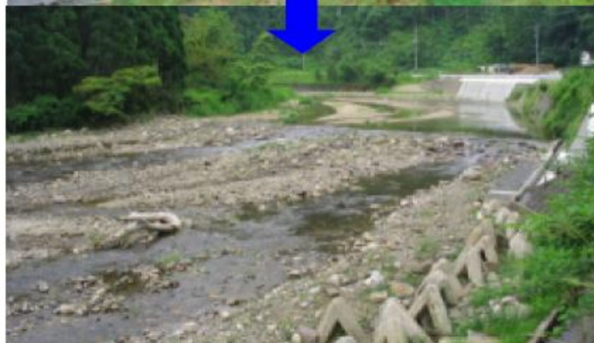
浚渫土の利用による落差の解消
