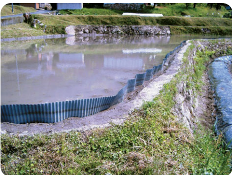
あぜ 畦シートによる漏水防止
