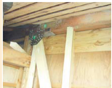
▲筋かいによる補強
