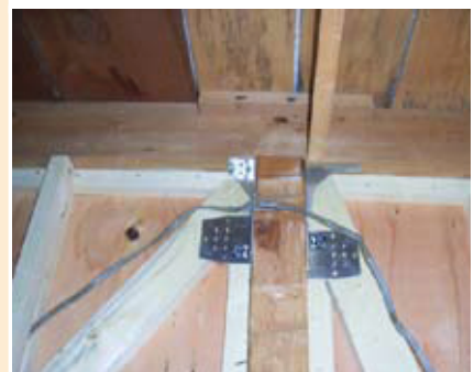
▲柱頭・柱脚及び筋かい端部の金物補強
