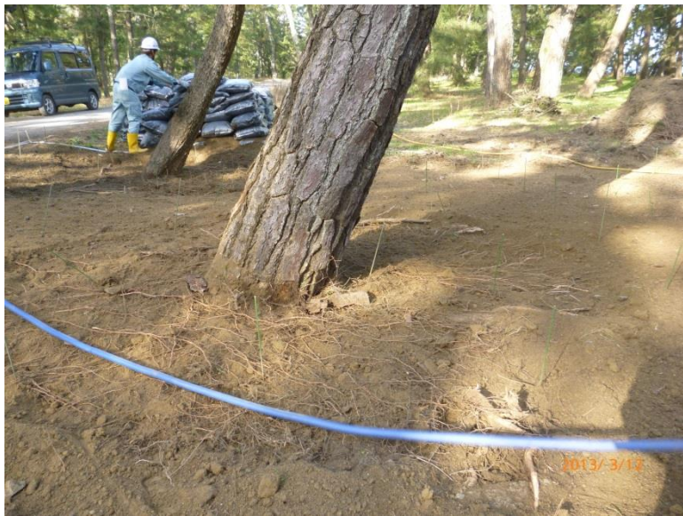
①重機とエアースコップにより表層の除去
