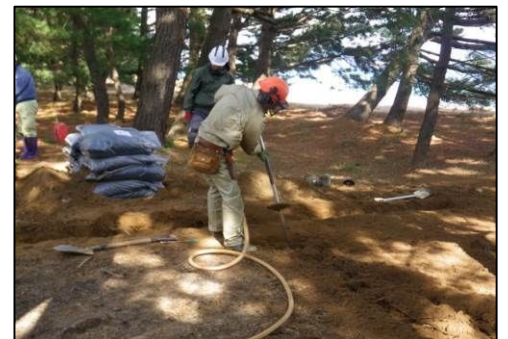
《エアスコップによる表層土壌の剥ぎ取り》 【施工方法1の例】
