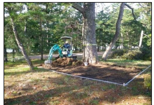
《重機による表層土壌の剥ぎ取り》 【施工方法2の例】
