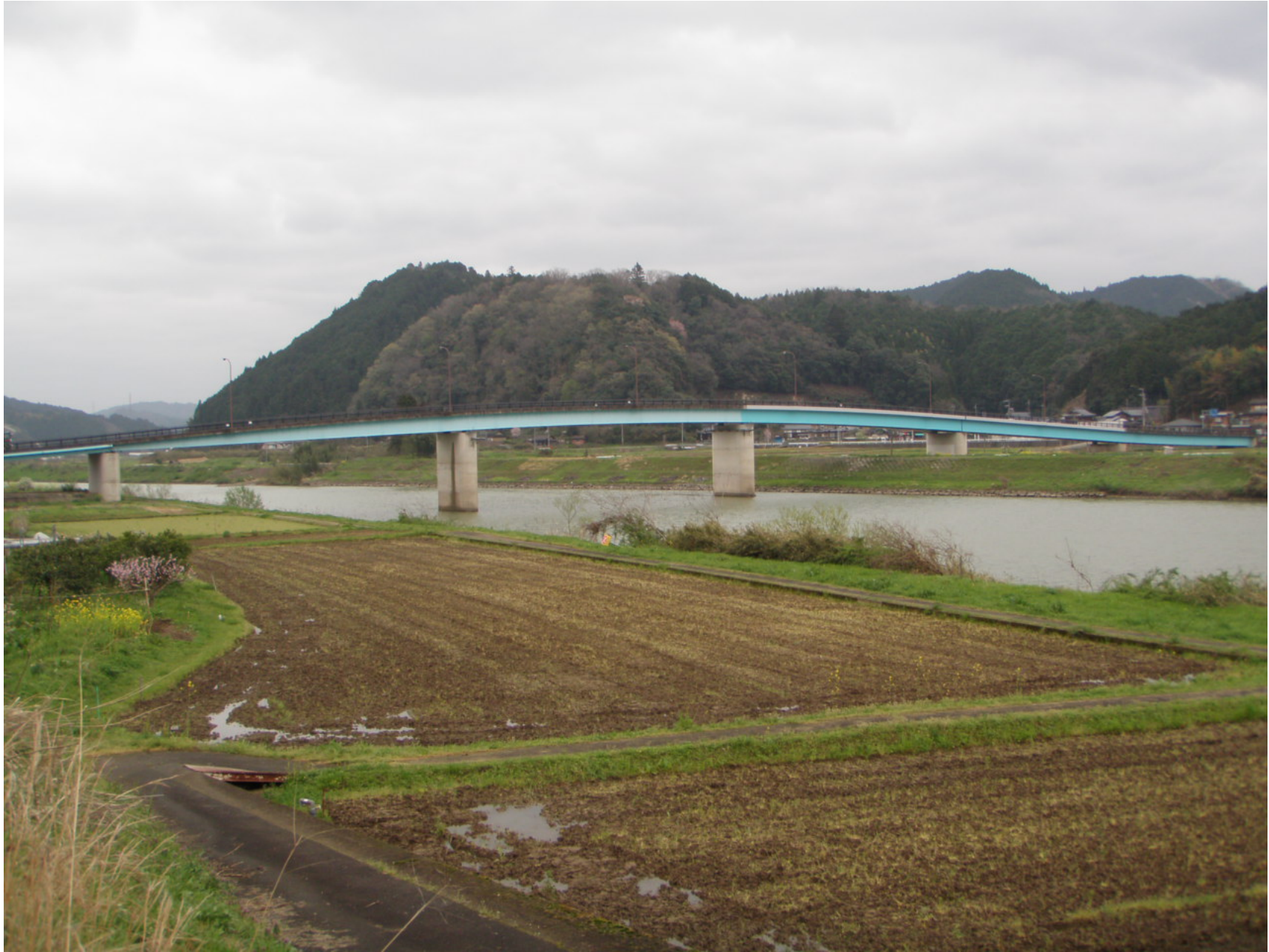
由良川 由良川橋
