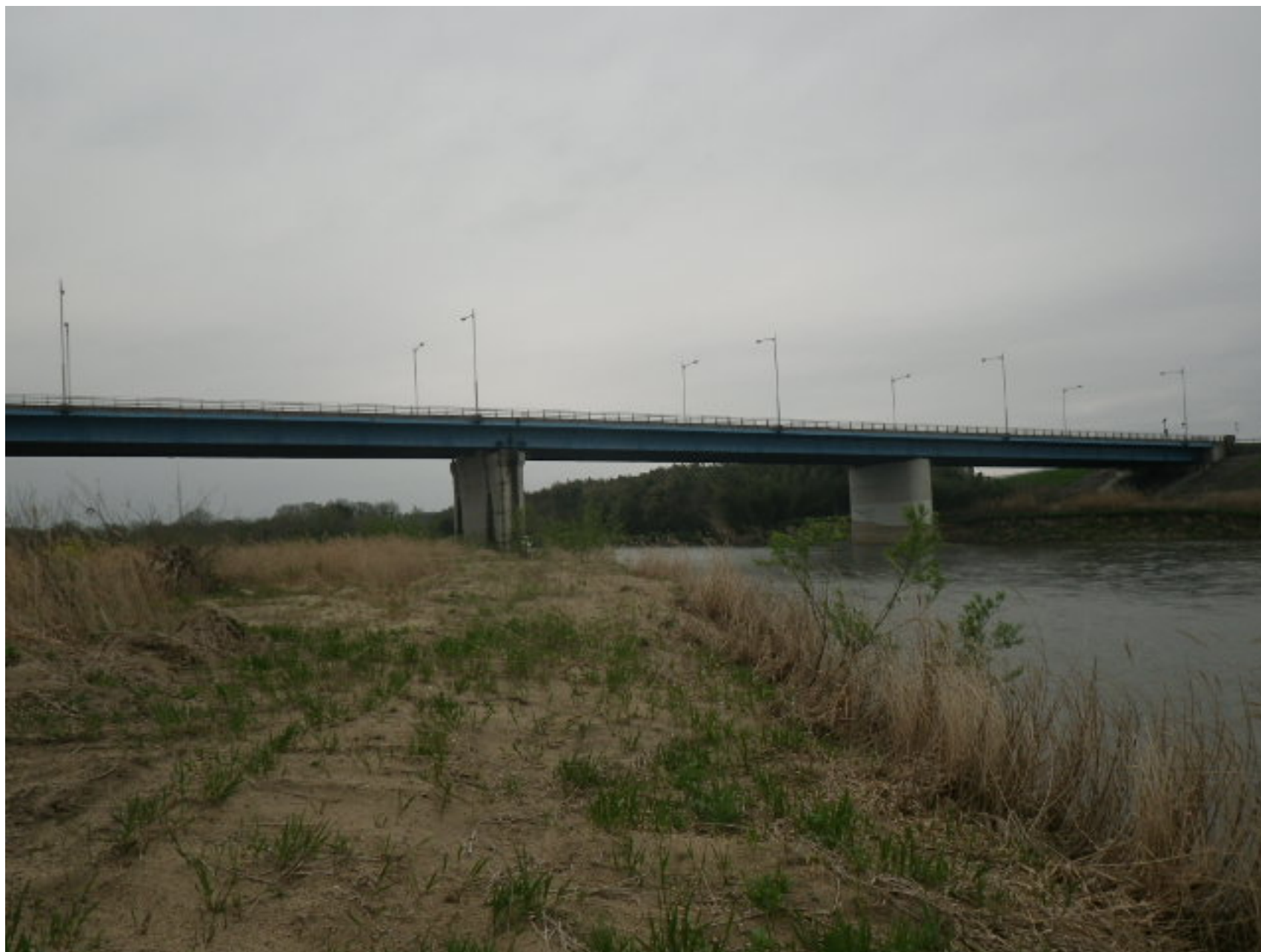
木津川 玉水橋
