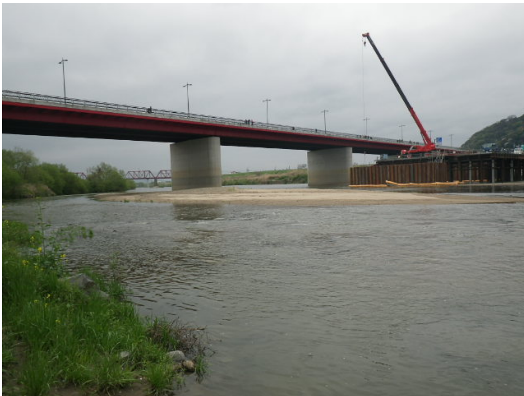
木津川 木津川御幸橋
