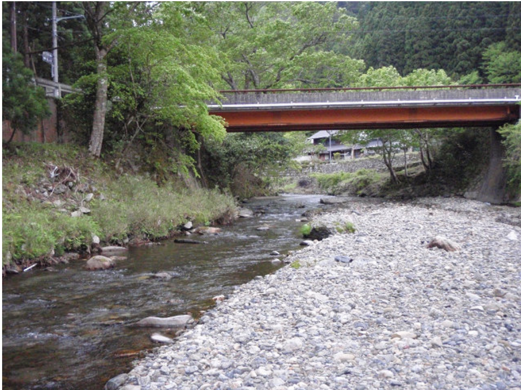
久多川 川合橋
