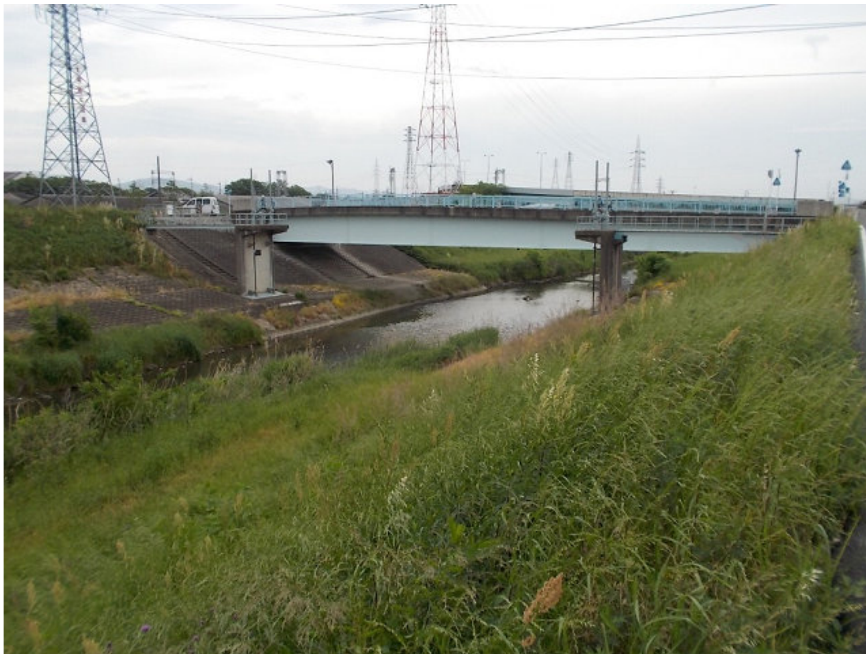
東高瀬川 三栖橋
